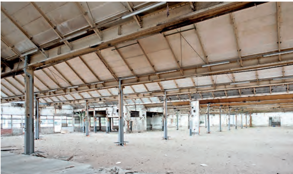
Die Shedhallen werden momentan für 9 Mio. Euro saniert.
