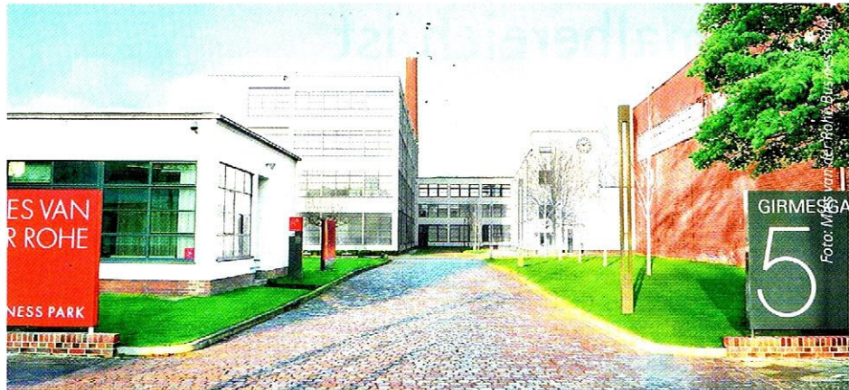
Die Sanierungen im Mies van der Rohe Business Park schreiten voran, einige sind bereits abgeschlossen.
